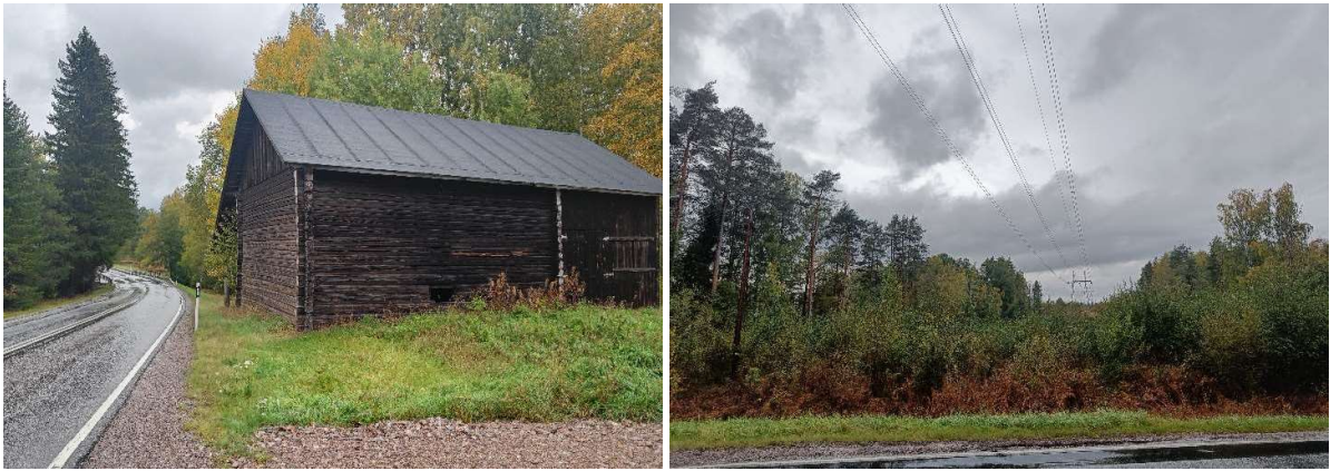
Kuvat 8ab. Rakennus kanava-alueen eteläpuolella (vas.) ja sähkölinja, joka kulkee alueen läpi (oik.).
