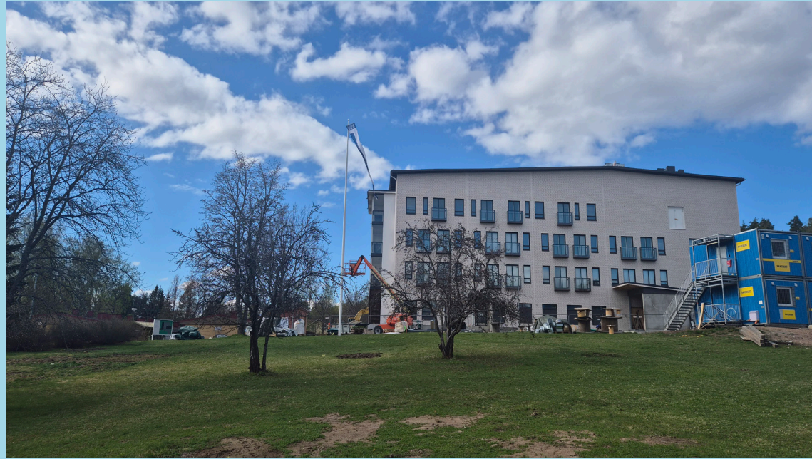
Kuva: Virastotien ja Satamatien välinen puistoalue ja taustalla pian valmistuva Rasilantie 61 –uudisrakennus. / Ruokolahden kunta
